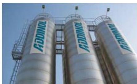
Цистерны производственного здания в Лейна
